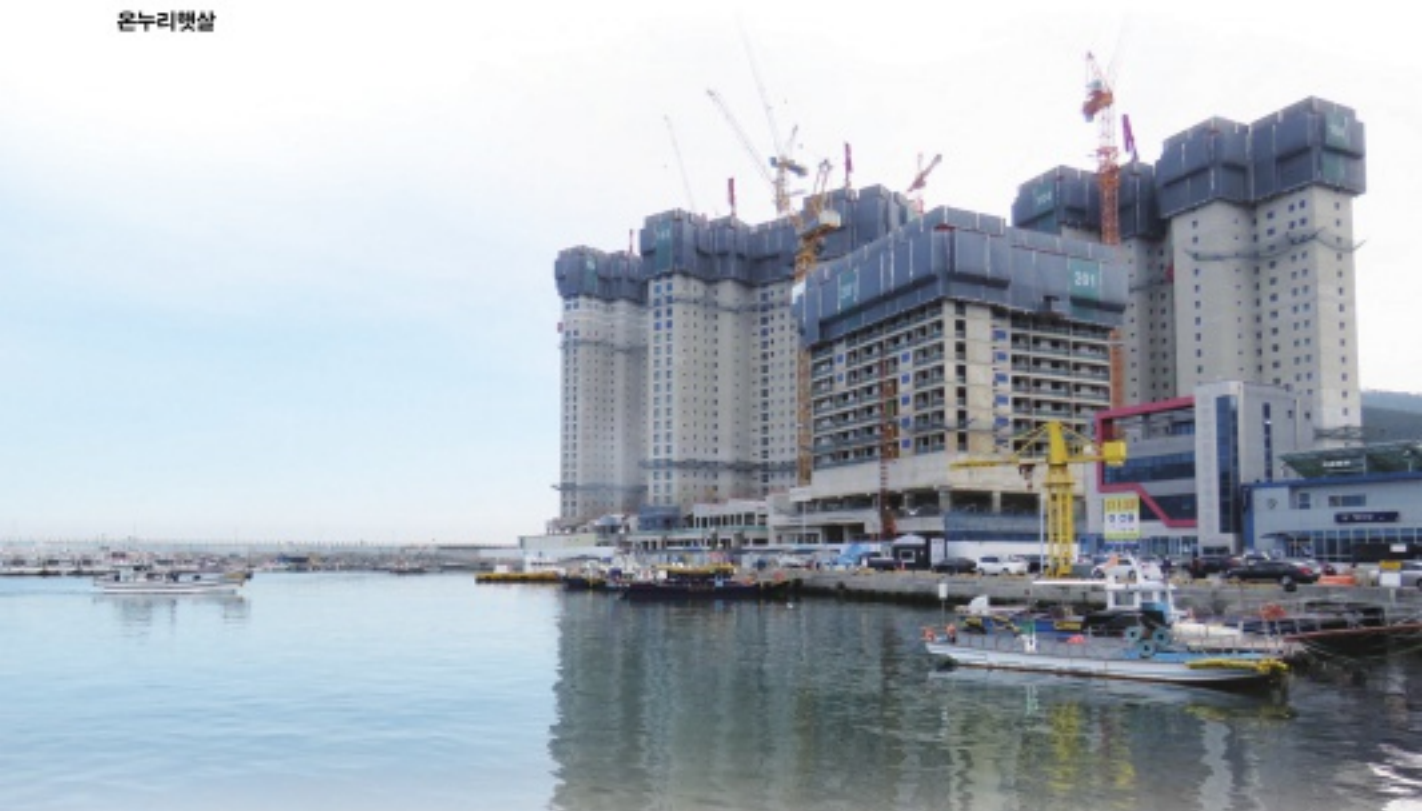
영도 하리 모션시티 푸르지오 마파르 건설 현장
