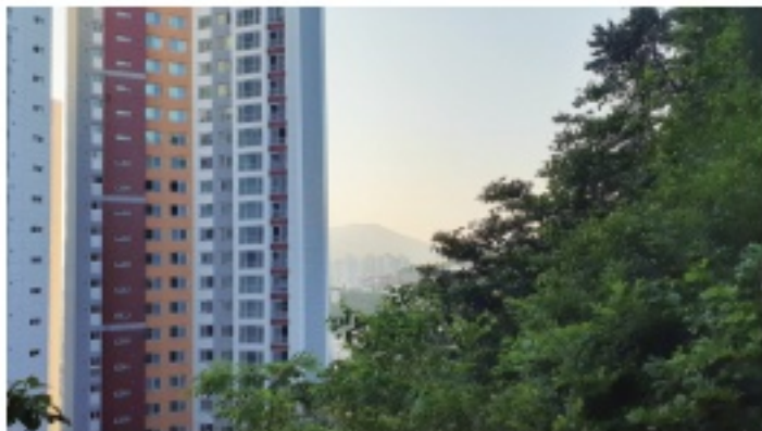
문현동 통일동산 거장자리를 덮고 들어선 경동아파트
